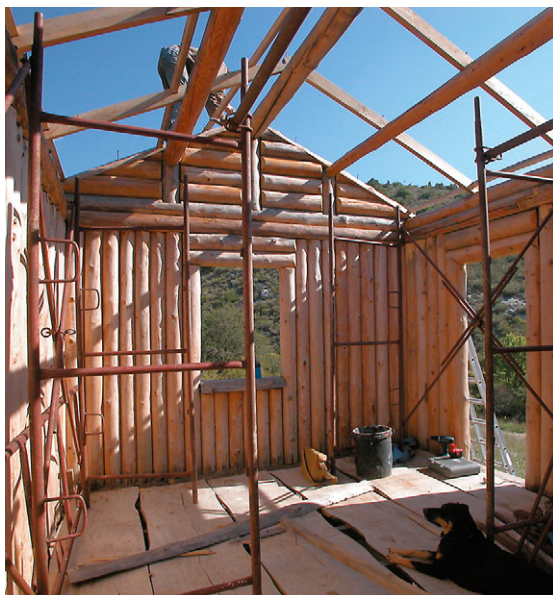
Le chalet de Fabrice en construction.
